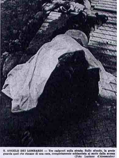
S. ANGELO DEI LOMBARDI - Tre cadaveri sulla strada. Sullo sfondo, la gente guarda quel che rimane di una casa, completamente sbriciolata al suolo dalla sismicità. (Foto Luciano d'Alessandro)
