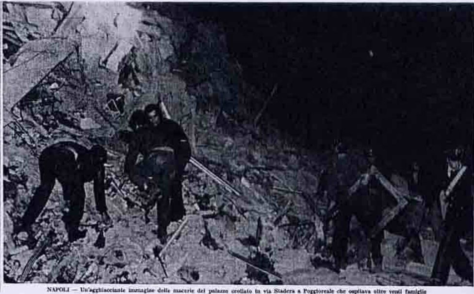
NAPOLI — Un'agghiacciante immagine delle macerie del palazzo crollato in via Stadera a Poggioreale che ospitava oltre venti famiglie
